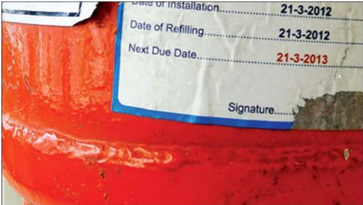
आकृति 3.4.1.3 अग्निशामक यंत्र पर उल्लिखित रीफिल की तिथि को जानें
